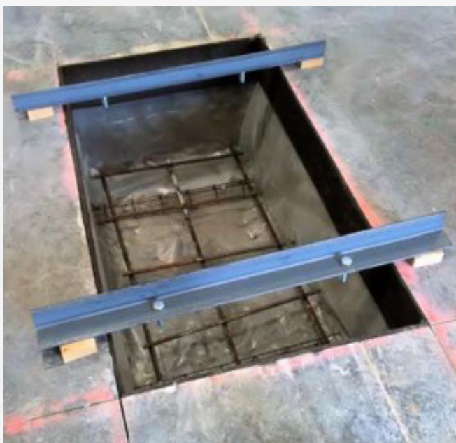
ATW, VTW, 及 AIT-238机器安装垫安装准备
